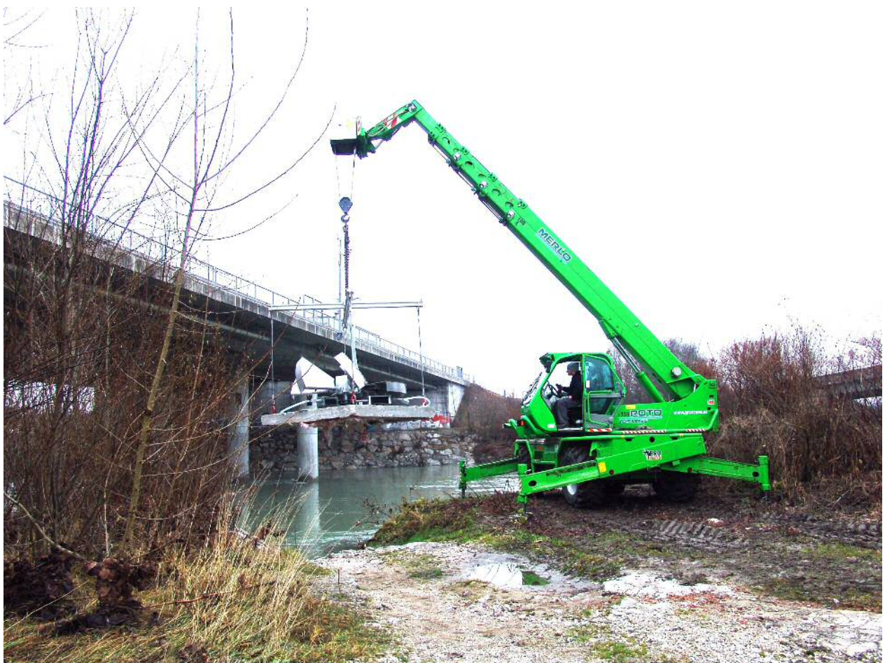
Fotografija iz 2009. godine. Spuštanje uređaja SP 1 na dno Save u blizini Ljubljane
