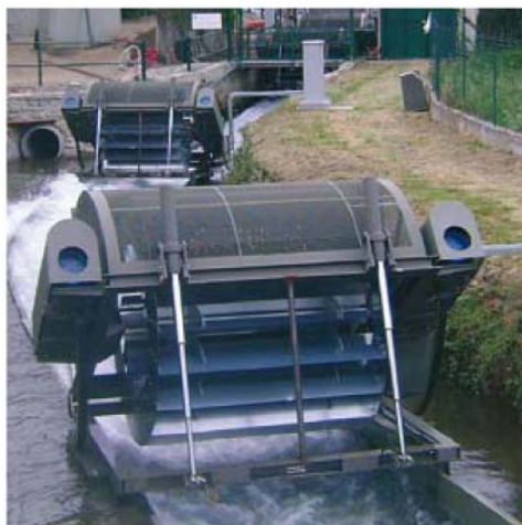
Sl.1 – vodna kolesa med servisom
